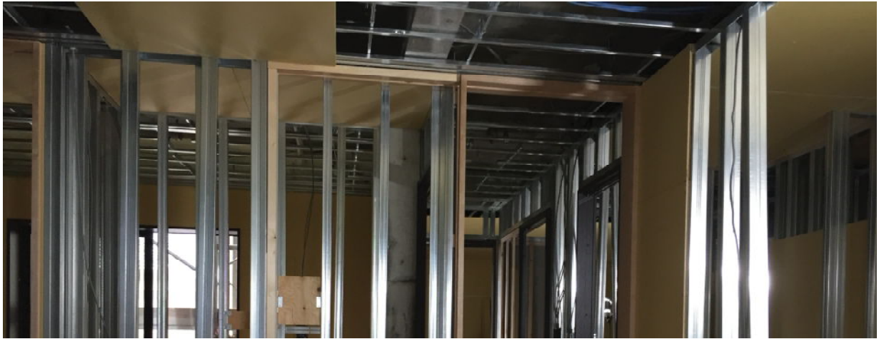
内部間仕切：軽量鉄骨なので簡単に改修可能です。木造のように柱はありません。
