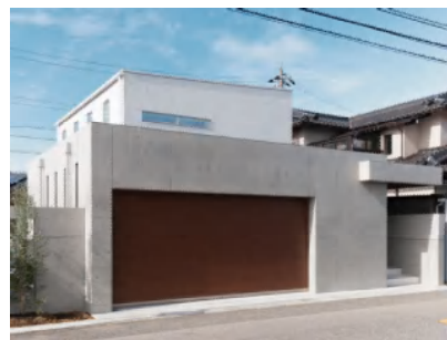
コンクリート車庫
